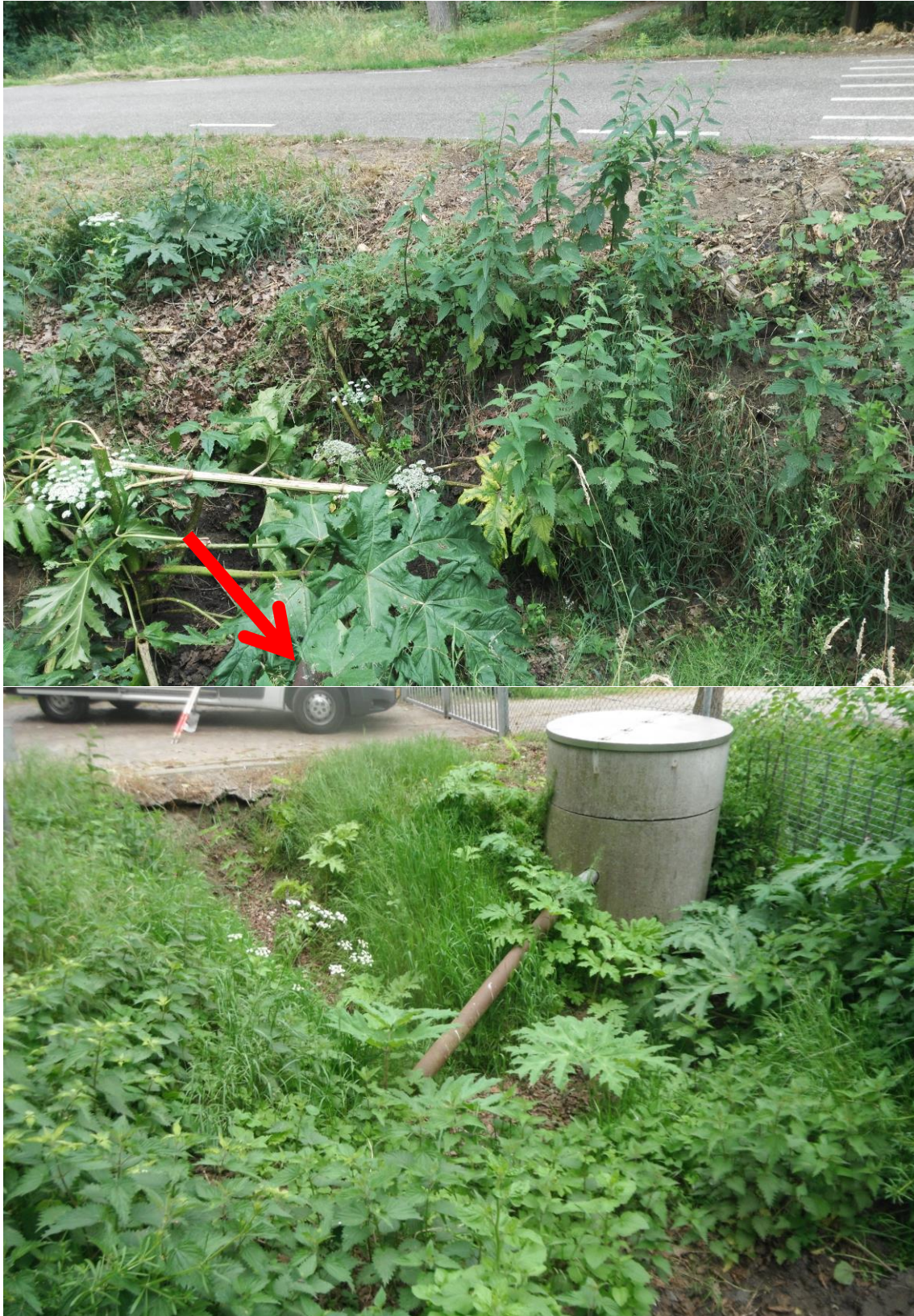
Abbeelding 3: Vanaf drain/pompput ingang voetbalterrein, ijzeren buis richting duiker (pijl). Deze zit onder de grond.
