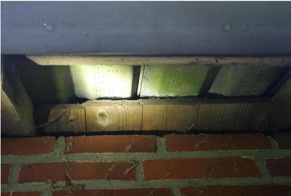
Figuur 9. De spouw van de schuur achter het woonhuis is afgesloten met een muurplaat (de planken op de foto liggen op deze muurplaat).
