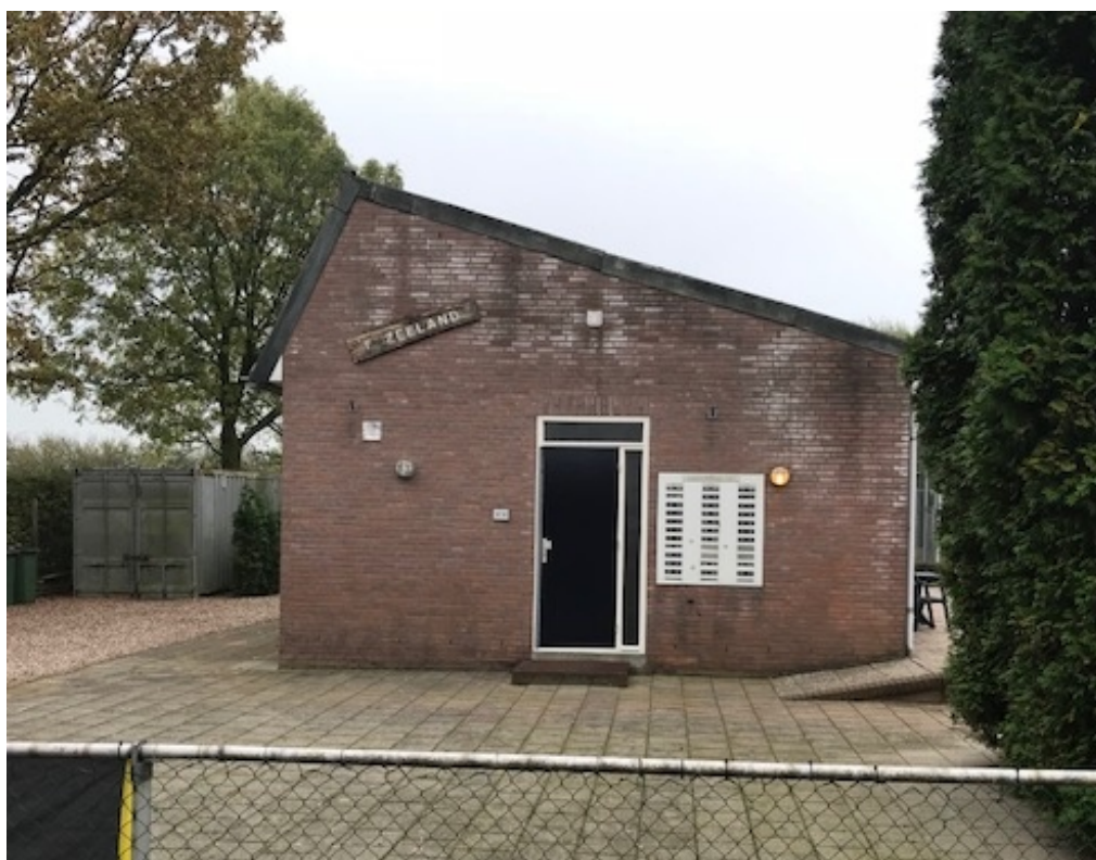
Gevel clubhuis: scherm 3,5 meter
