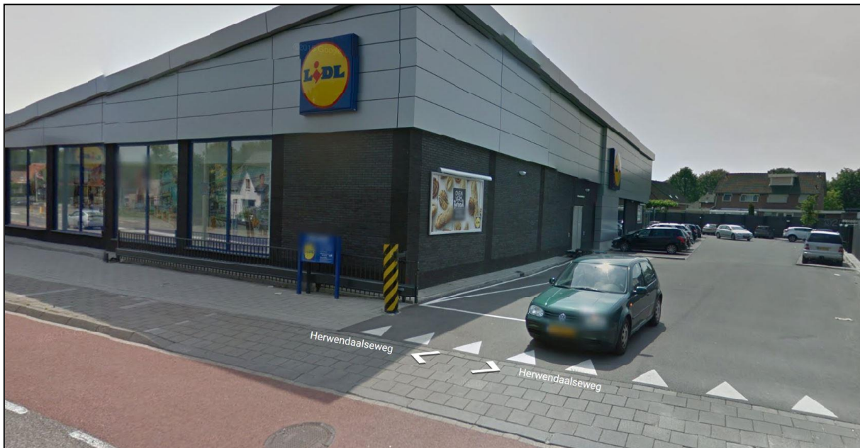
Bestaande situatie supermarkt en in- en uitrit bestaand parkeerterrein.
