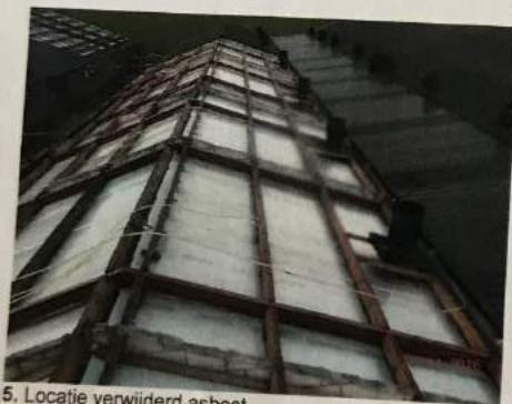
5. Locatie verwijderd asbest.
