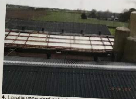
4. Locatie verwijderd asbest.
