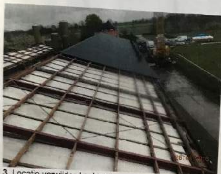
3. Locatie verwijderd asbest.
