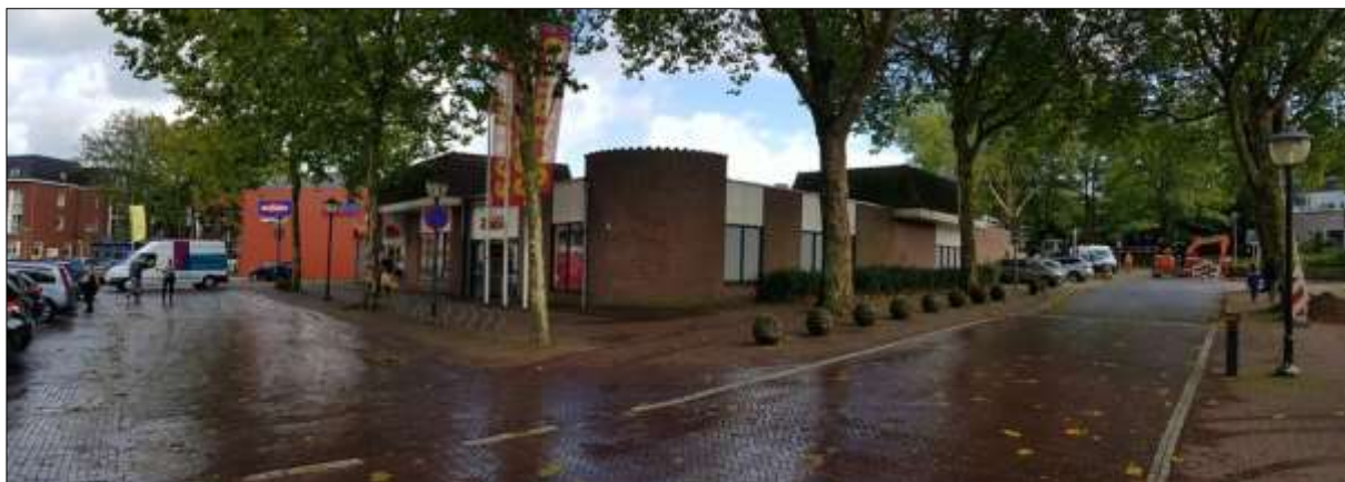
Zicht op de bestaande en nog te slopen bebouwing.
