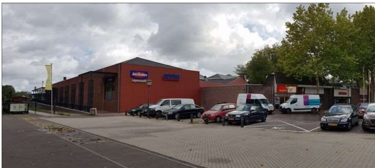
Zicht op de nieuwbouw langs de spoorzijde met rechts de nog te slopen bebouwing.
