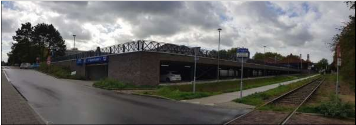
Parkeerkelder langs het spoor.
