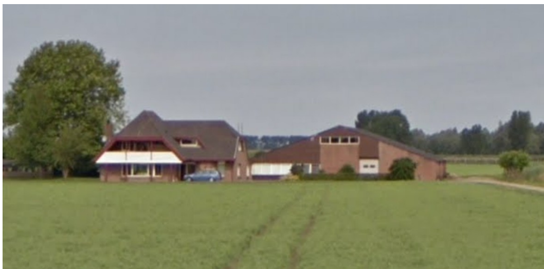
Figuur 4: Foto vanuit het zuiden, kijkend naar het noorden.
