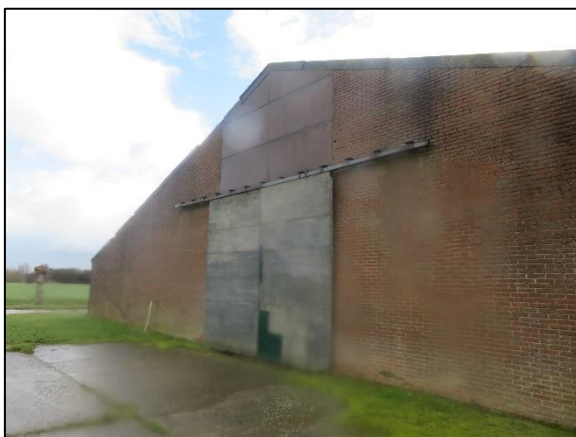
Foto 3. Achterkant van de schuur, gezien vanuit het noordoosten
