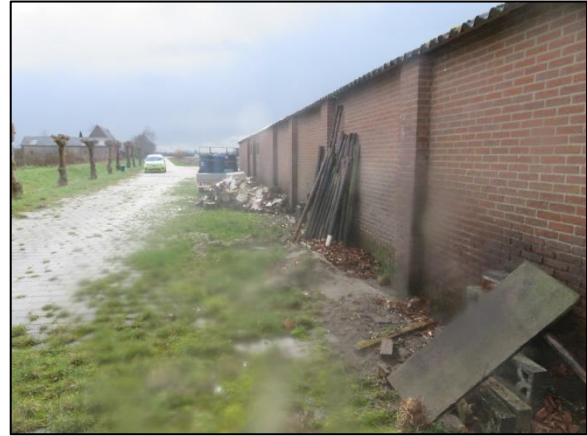
Foto 6. Erfverharding (oprit) langs schuur
