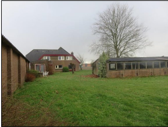
Foto 5. Bedrijfswoning gezien vanuit het noordwesten met links de schuur en rechts een bedrijfsgebouw met fazantenkooien
