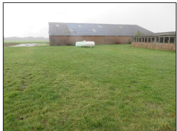
Foto 4. Schuur gezien vanuit het zuidwesten, met daarlangs nog een bedrijfsgebouw
