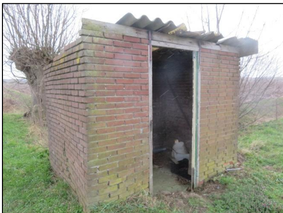
Foto 5. Buitenkant van het klein schuurtje (5) in het westen van het plangebied met overhangende dakplaten en openingen
