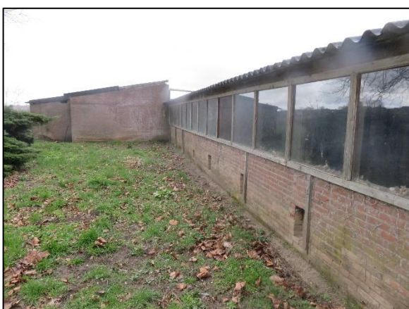
Foto 3. Buitenkant van de fazantenkooien (4) met overhangende dakplaten
