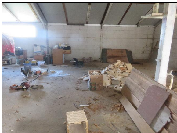
Foto 1. Binnenkant van de grote schuur (2) in het noorden van het plangebied
