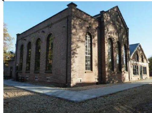
voormalig machine- en ketelgebouw, later met werkplaatsen
