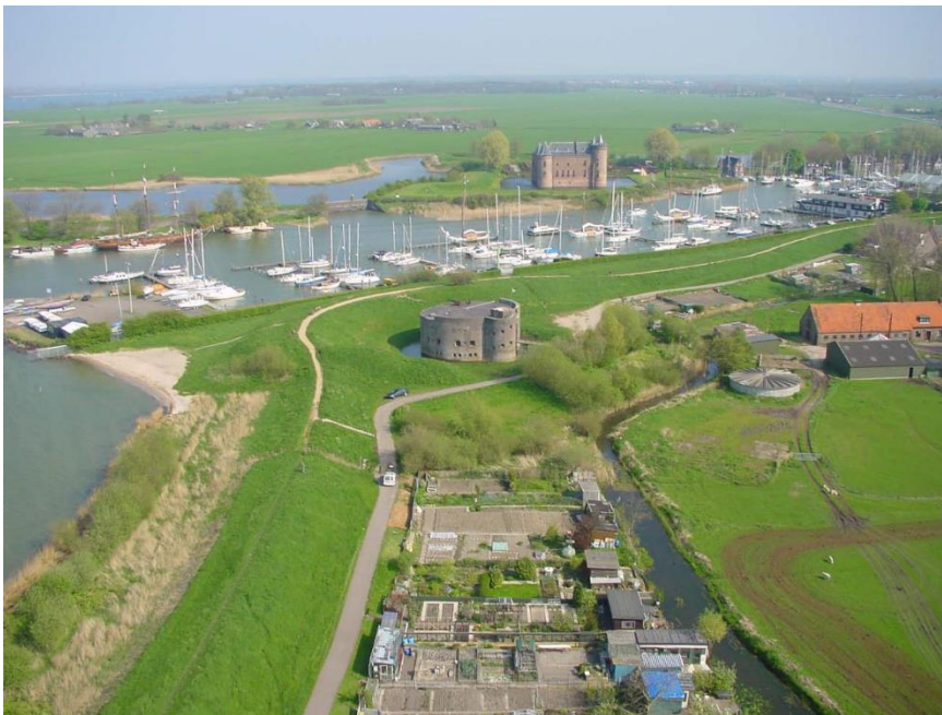
Afbeelding 7: De Westbatterij met op de achtergrond de Vecht en het Muiderslot. Op de foto is de boerderij ten zuiden van de Westbatterij te zien (foto 2005), deze is in de huidige situatie niet meer aanwezig.
