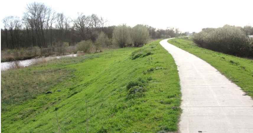
Afbeelding 2: Diemerdijk ten noorden van het fabrieksterrein
