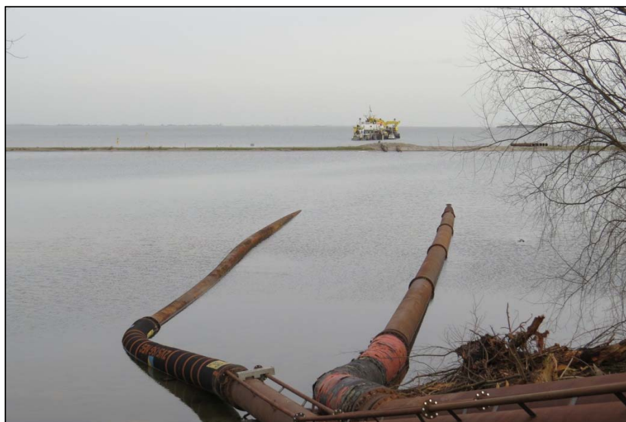
Leidingen voor zandtransport naar hydrolische grondpers op ponton achter de luwtedam, met rechts daarachter het eiland Pampus.
