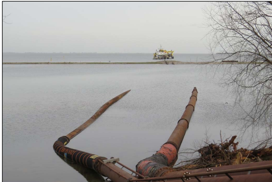
Leidingen voor zandtransport naar hydraulische grondpers op ponton achter de IJwtedam, met rechts daarachter het eiland Pampus.
