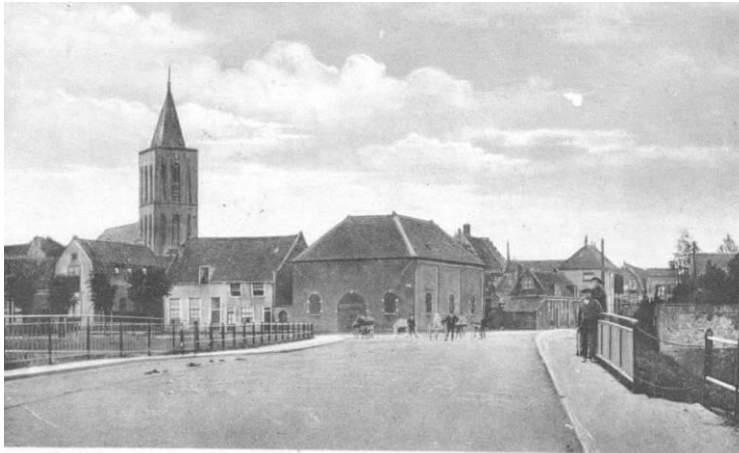
Vesting - westelijke entree
