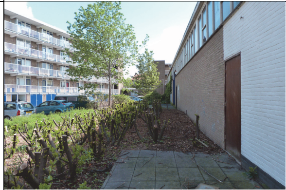
Openbaar groen noordzijde te slopen loods
