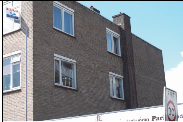
Noordgevel appartementen (thv geplande passage)
