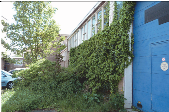
Vegetatie noordoosthoek te slopen loods
