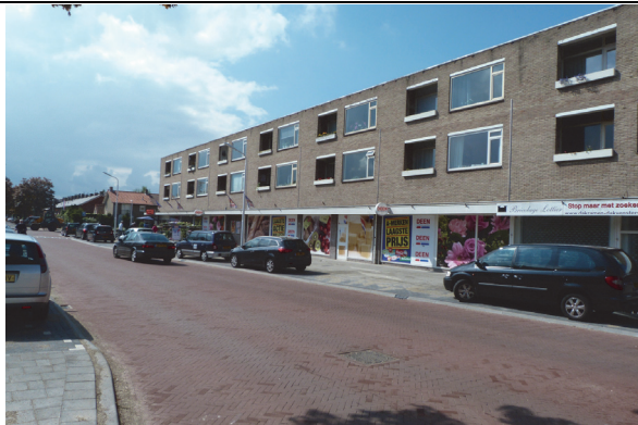
Voorzijde DEEN supermarkt en bovenliggende appartementen
