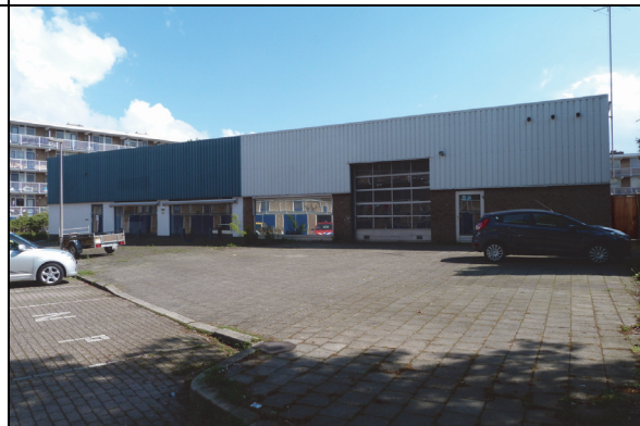
Westzijde te slopen loods binnen onderzoeksgebied
