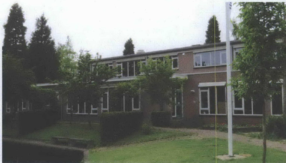
Foto 1. Schoolgebouw, strak afgewerkt en daardoor grotendeels ongeschikt en ontoegankelijk voor vleermuizen, gierzwaluw en huismuis.
