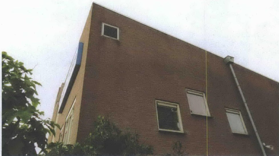
Foto 4. Detail van strak afgewerkt deel van het schoolgebouw zonder potenties voor vleermuizen, gierzwaluw en huismus.
