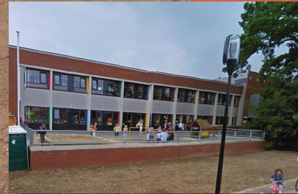
Omhullende bakstenen gevel
