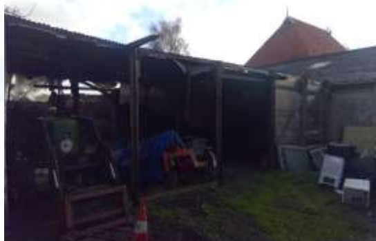
34 | Schuur met metalen dak
