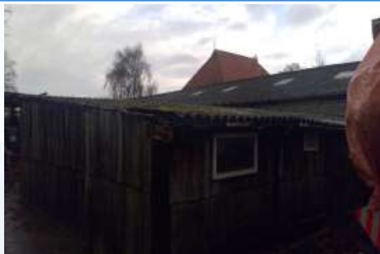
20 | Kapschuur met golfplaten
