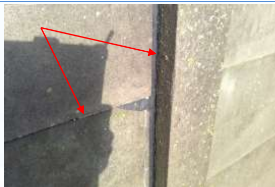
29 | Detail afdichtingskit
