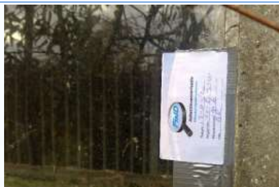
17 | Monstername stopverf betonnen kozijnen
