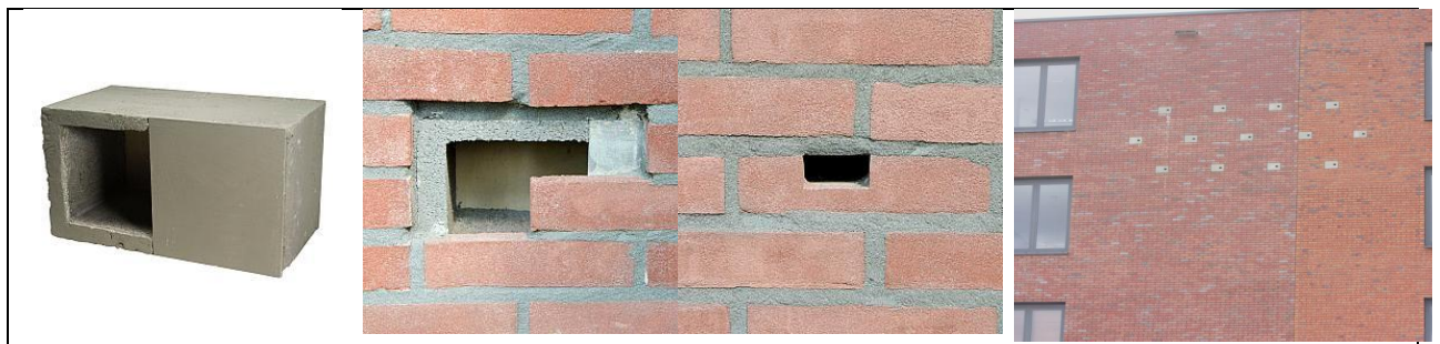
Figuur 5.3. Voorbeeld van een onzichtbaar ingemetselde inbouwnestkast voor gierzwaluwen (bron: Vivara). Via deze site kunnen de verschillende typen bekeken worden: http://gierzwaluwbescherming.nl/bescherming/neststenen/
