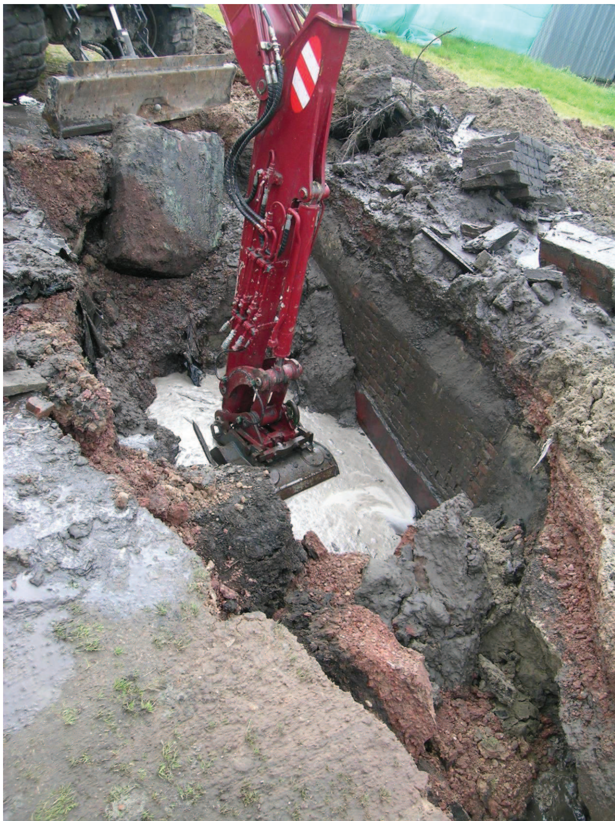
Foto 5: Materiaal uit kelder machinelokaal (sleuf 1, sectie 3, MM5).
