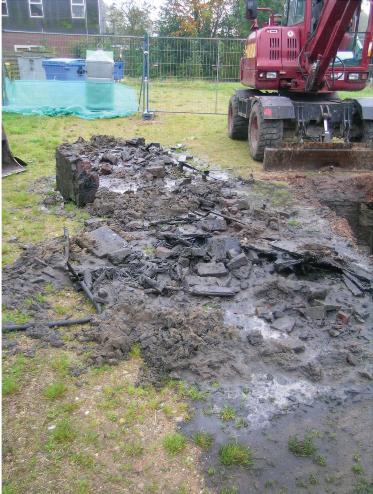
Foto 4: Materiaal uit kelder machinelokaal (sleuf 1, sectie 3, MM5).
