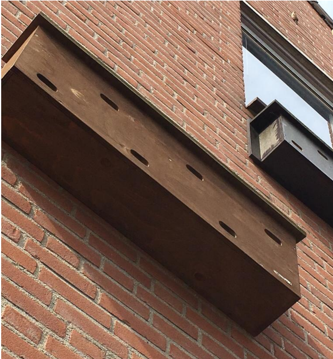
Figuur 2. Gierzwaluwkast van RANOX, geschikt voor zes gierzwaluwnesten.
