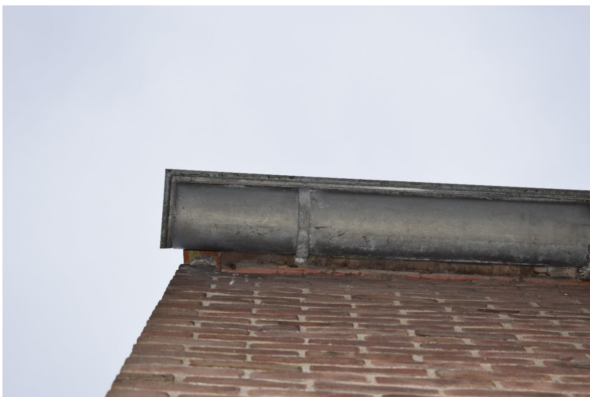
Figuur 8. Via deze ruimte kunnen vleermuizen ook de spouwmuur bereiken. Daarnaast is het ook groot genoeg om als aanvliegroute voor gierzwaluwen naar onder de dakpannen te fungeren.
