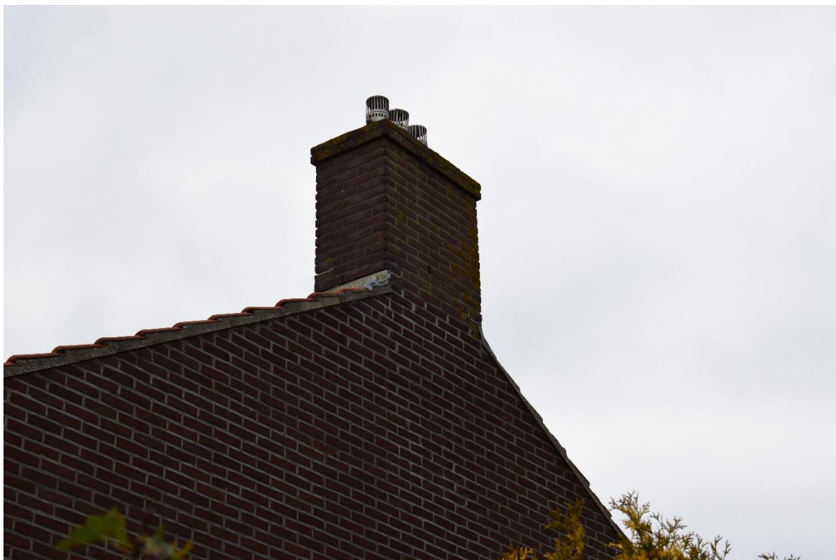
Figuur 11. Open stootvoegen zoals in deze schoorsteen kunnen gebruikt worden door vleermuizen om de spouwmuur te bereiken, mits er voldoende 'valruimte' is om weg te kunnen vliegen.
