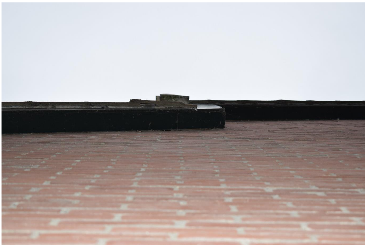
Figuur 12. Tussen de gevelbetimmering en de wand van het appartementencomplex is voldoende ruimte voor vleermuizen om onder weg te kruipen.
