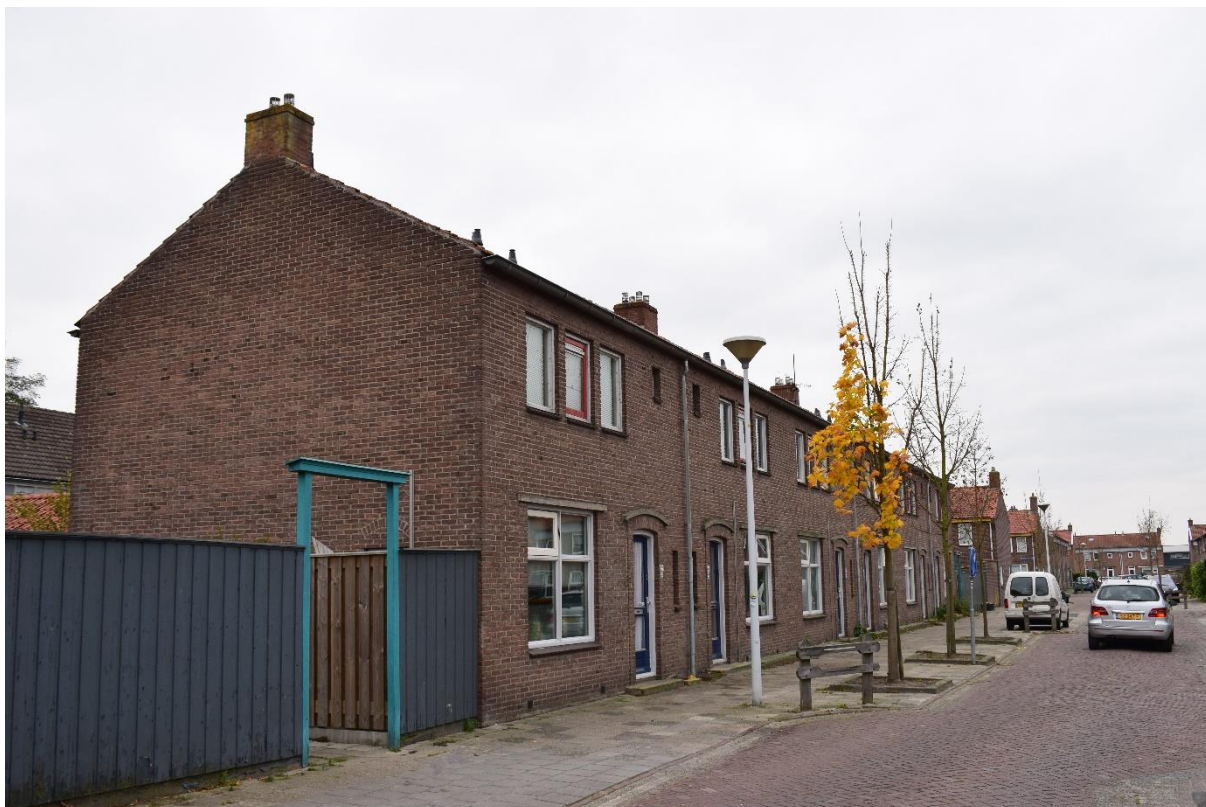
Figuur 3. De bouwstijl van woningen aan zuiderzeestraat 53-63.
