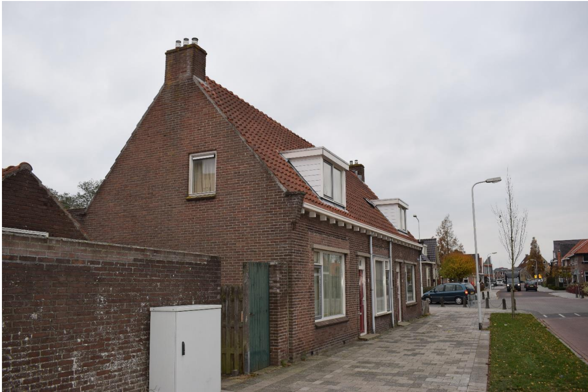
Figuur 5. De bouwstijl van de huizen aan Flevostraat 10 en 12.
