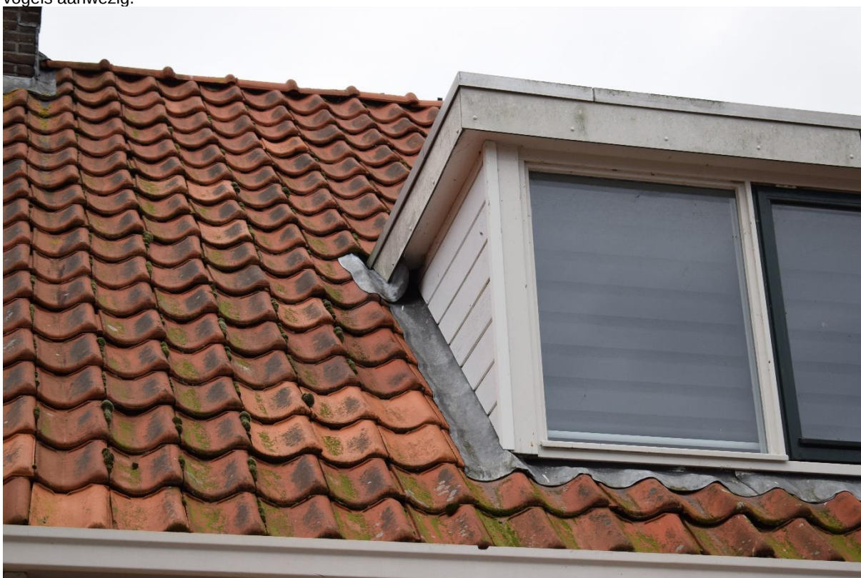
Figuur 10. De ruimte onder de nokpan en bij hoekjes van loodslabben van dakkappen kunnen gebruikt worden door gierzwaluwen.
