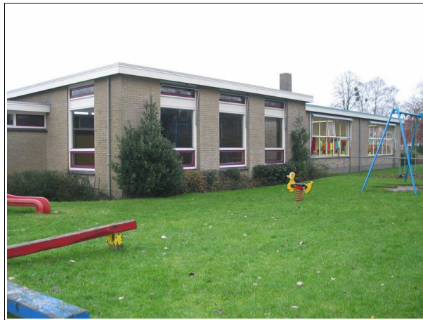
Figuur 2: Joure, Lyts Luchtenveld 2: foto van de school gezien in westelijke richting voordat deze gesloopt werd. Bron: www.joustercourant.nl .
