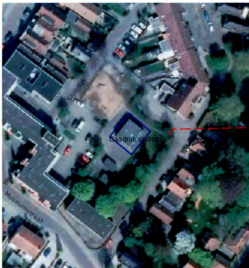
Figuur 2: gasdrukmeet- en regelstation
