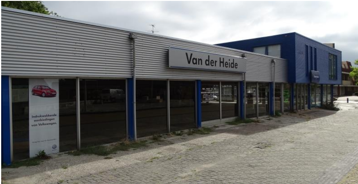
Figuur 2.2. Vooraanzicht van de showroom gezien vanaf de Dubbelstraat.
