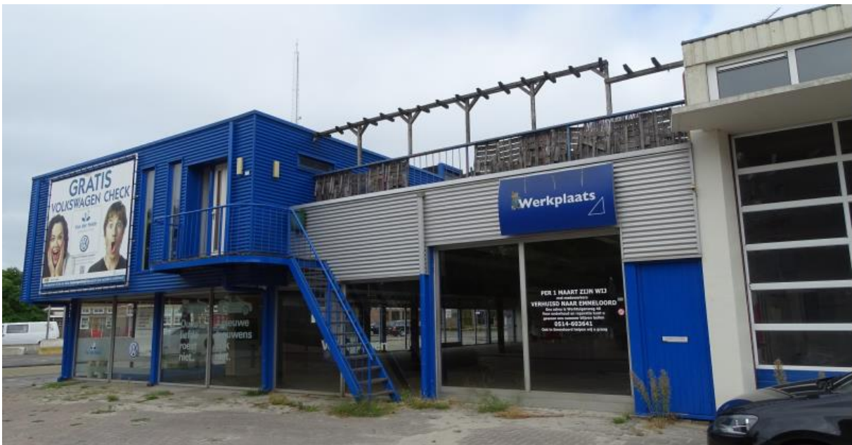
Figuur 2.5. Vooraanzicht van de werkplaats gezien vanaf de Jachthavendyk.
