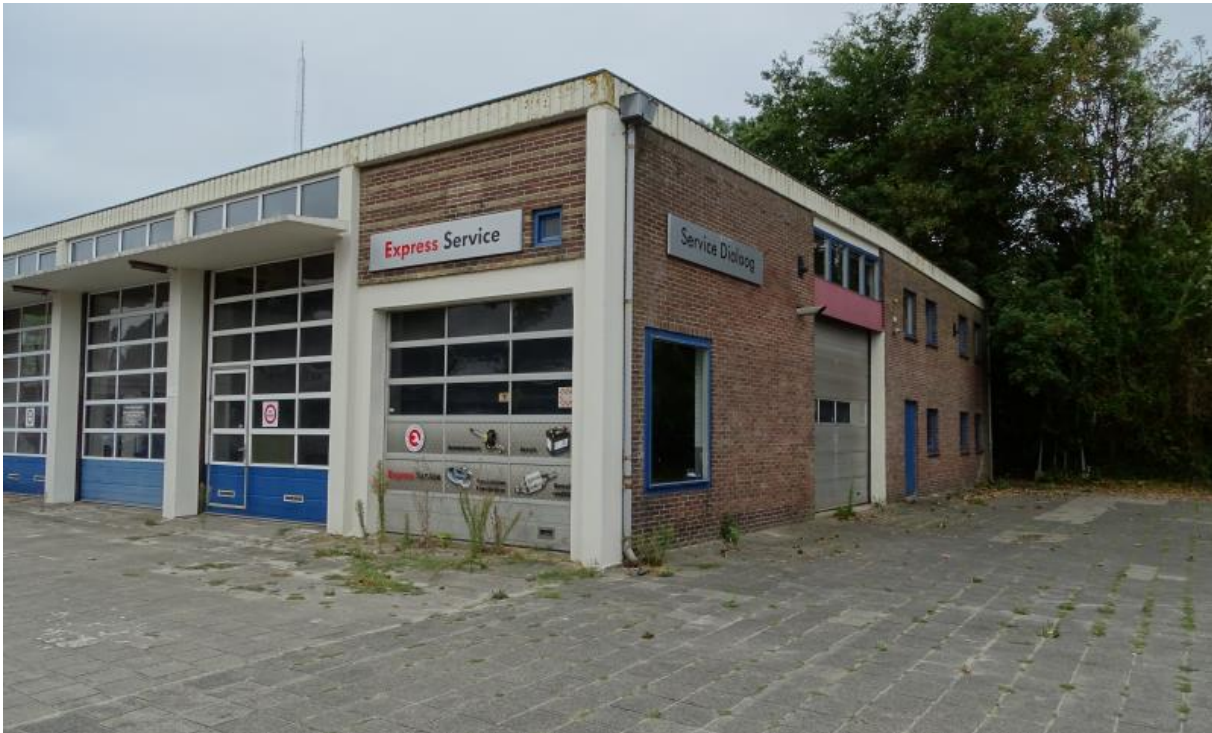
Figuur 2.4. Vooraanzicht van de garage / werkplaats gezien vanaf Jachthavendyk.
