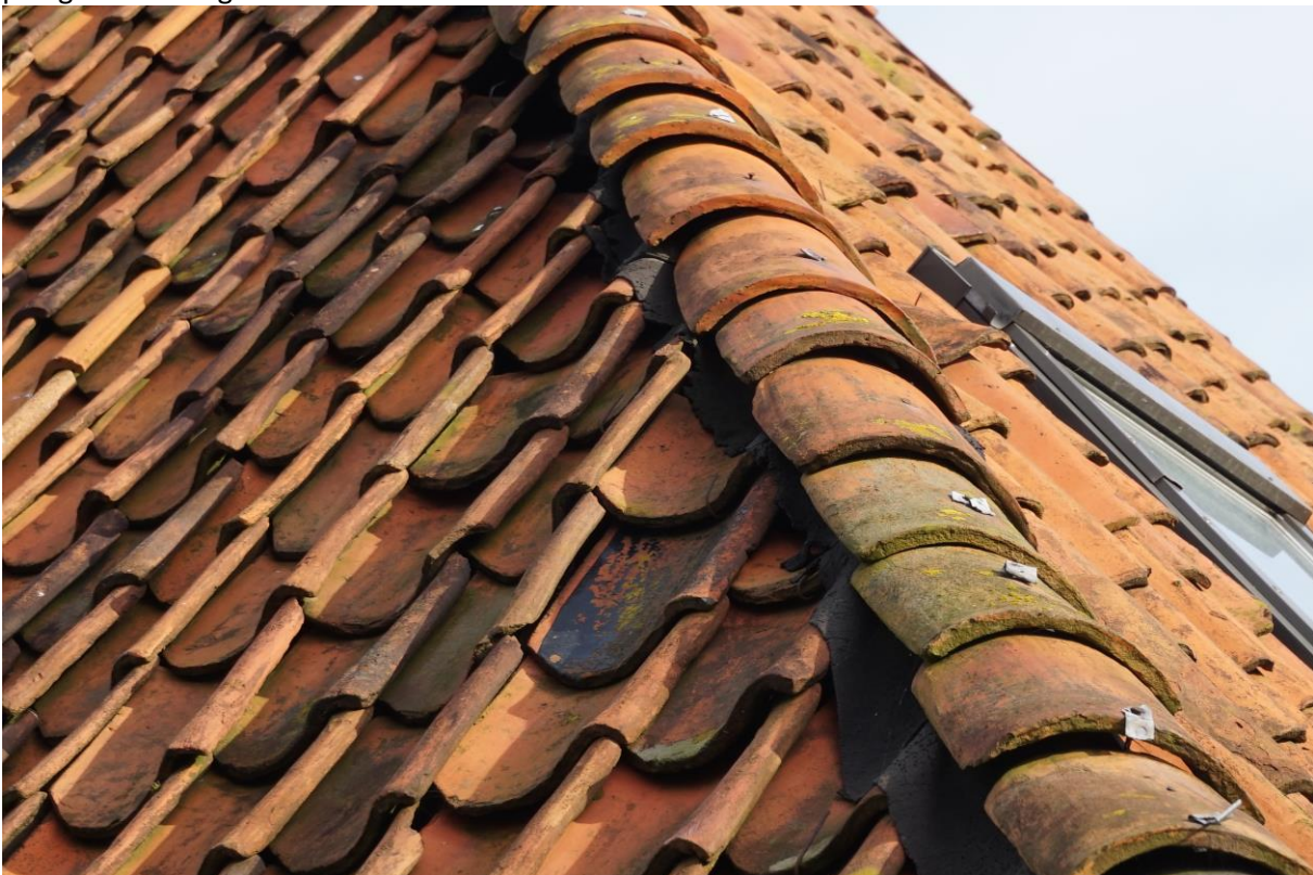
Figuur 3.1 De oud Hollandse dakpannen bieden toegang tot het dak.
