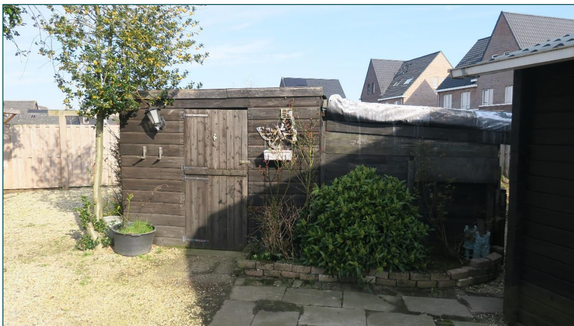
Figuur 3 Schoor 2 (linker helft) en 3 (rechter helft) zijn opgetrokken uit houten schroten en daken van damwandplaten of golfplaten en zeil.
