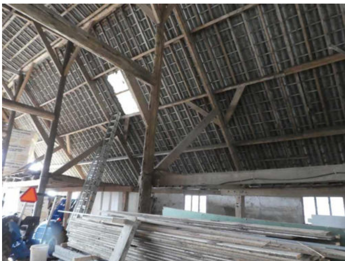
Figuur 18 Dakconstructie binnenzijde, zicht op dak
