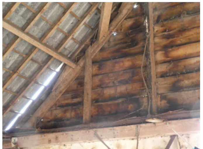
Figuur 16 Gepotdekselde wand zonder binnenbetimmering
