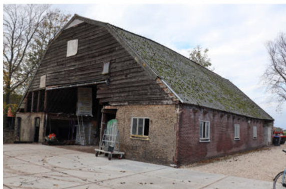
De te vervangen schuur vanaf achterzijde.
