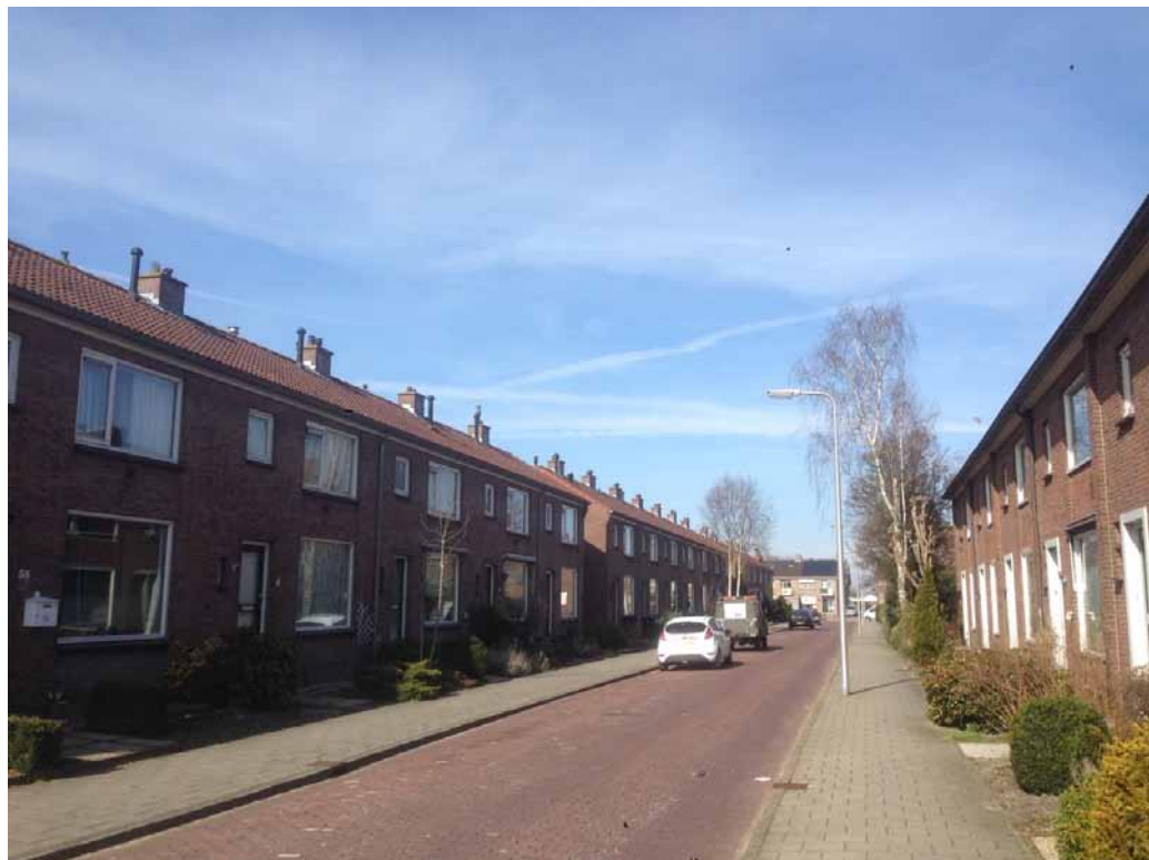
Figuur 2 De rijtjeswoningen worden voorzien van nieuwe, geïsoleerde daken. Tevens worden spouwruimtes geïsoleerd en kozijnen vervangen.
