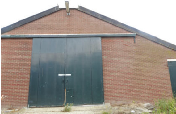
Afbeelding 12: Gevel aan de zuidzijde van schuur 6. Houten boeiboorden langs het dak zijn zichtbaar. Foto: C.E. Bakker | Ecoresult B.V.
