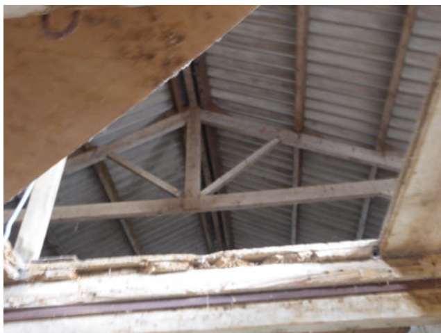
Dakconstructie schuur 1. Foto: C.E. Bakker | Ecoresult B.V.
