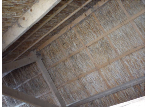
Afbeelding 9: Binnenkant dak met riet in schuur 3. Foto: C.E. Bakker | Ecoresult B.V.
