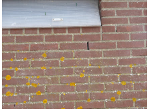
Afbeelding 13: Stootvoegen in zijgevels van schuur 6. Foto: C.E. Bakker | Ecoresult B.V.
