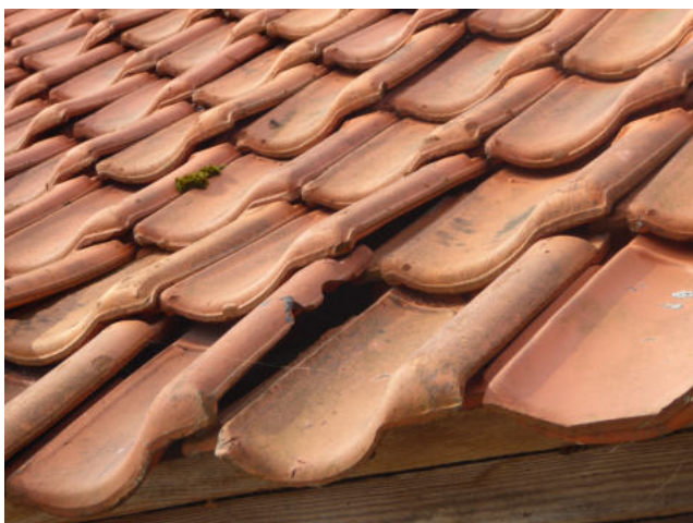
Wijkende dakpan van schuur 3. Foto: C.E. Bakker | Ecoresult B.V.
