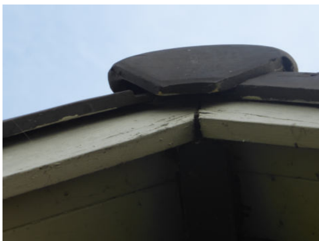
Wijkende nokpan van gebouw 2. Foto: C.E. Bakker | Ecoresult B.V.
