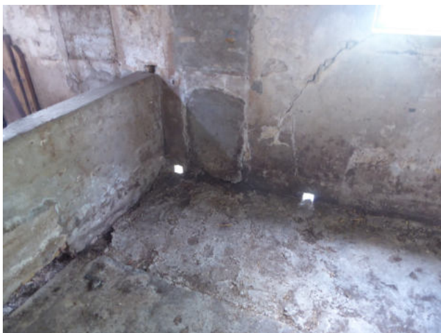
Waterafvoergaten in gevel van schuur 1. Foto: C.E. Bakker | Ecoresult B.V.
