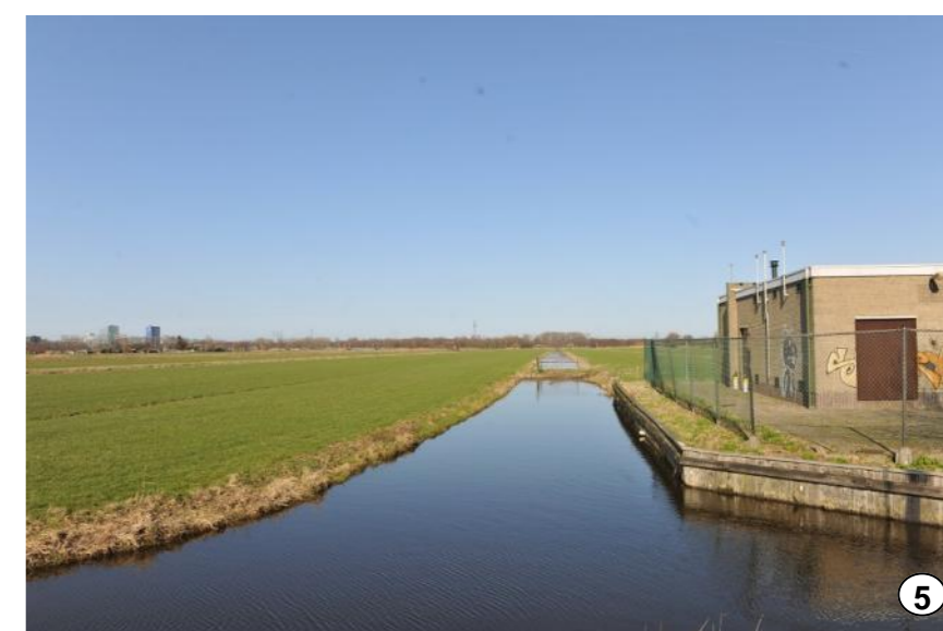
5 Trafo in open polder landschap met harde gebiedsvreemde oevers.
