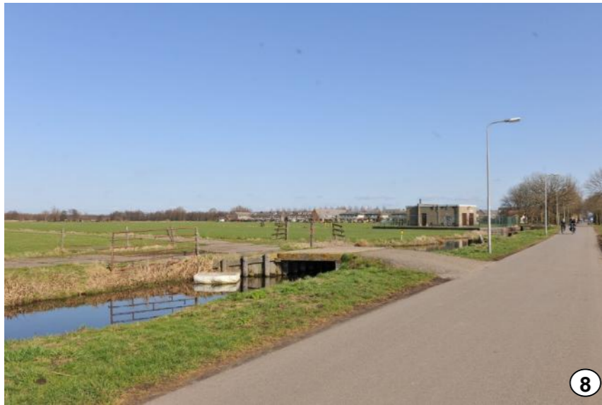
Verrommeling nabij trafo.
