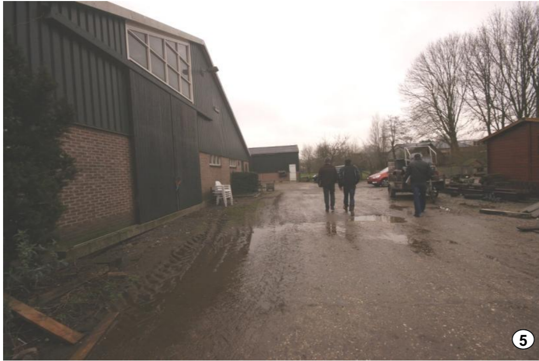
Voorzijde (zuidzijde) ligboxenstal
