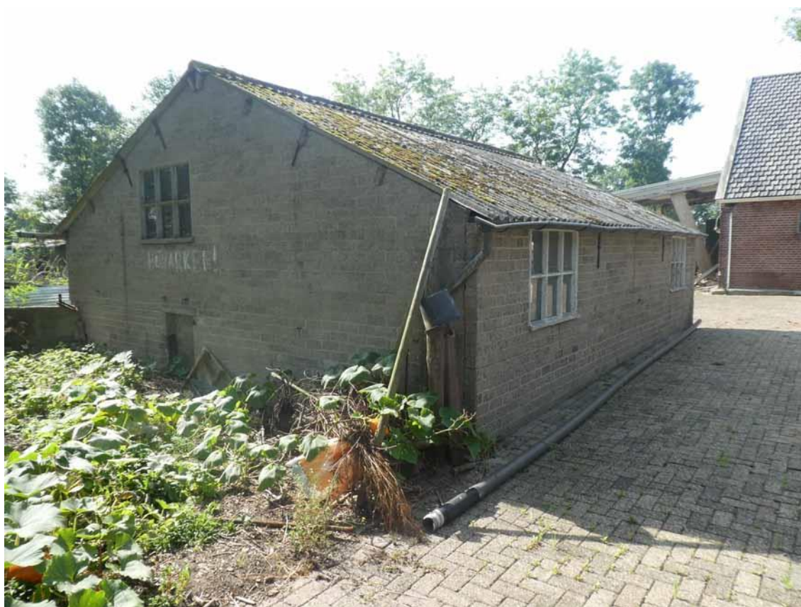
Figuur 3 Te slopen schuur
