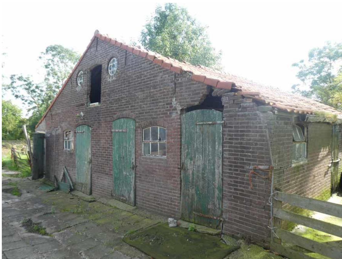
Figuur 4 Te slopen schuur
