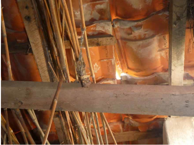
Figuur 13 Dakconstructie binnenzijde zonder ruimtes
