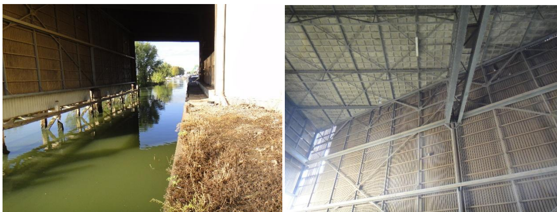
Figuur 6. De overkapping boven de loskade die zal worden afgebroken.
