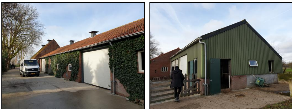
Figuur 2 Fotografische indruk van de planlocatie en de directe omgeving hiervan. Links: de schuur die in gebruik is als materiaalopslag. Rechts: de schuur die in gebruik is als geitenstal/kippenren.
