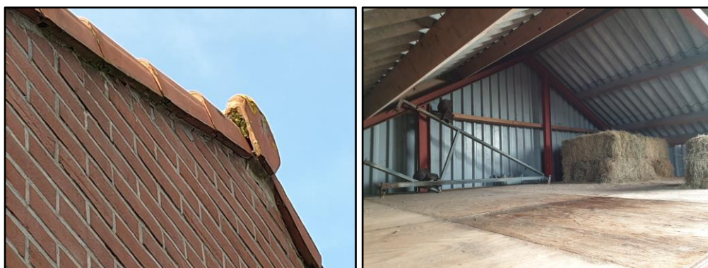
Figuur 5 Links: de kantpannen van de materiaalopslag zijn dichtgemaakt met specie. Rechts: de open dakruimte van de geitenstal/kippenren, waar geen potentie is voor gebouwbewonende vleermuizen.
