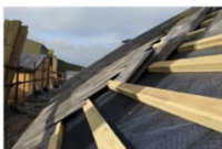
Figuur: de panlatten komen boven de gaaslaag.
