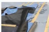
Figuur: het aanbrengen van de gaaslaag (Netlon® mesh type XN1081-8000) op de tengels.
