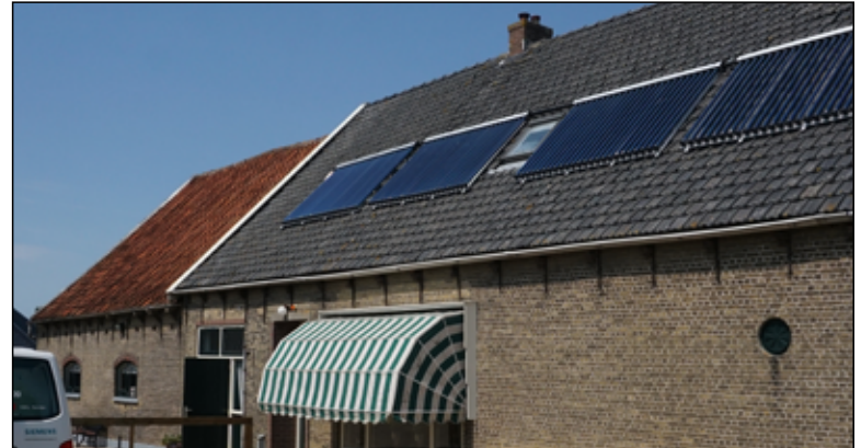
Figuur: het woonhuis heeft geschikte nestplaatsen voor huismussen in de dakrand tussen de dakpannen.
