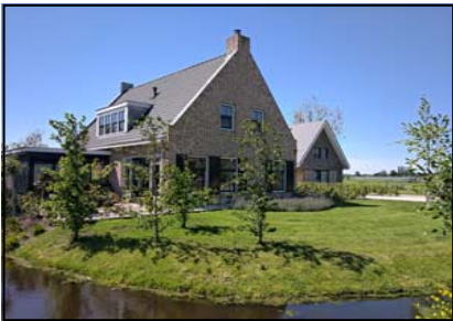
Hoofdwoning van ensemble onderscheidt zich in mate van detaillering en voornaamheid in uitstraling ten opzichte van de overige woningen en bijgebouwen. Metselwerk woning voorzien van zadeldak met riet of zwarte keramische dakpan.
