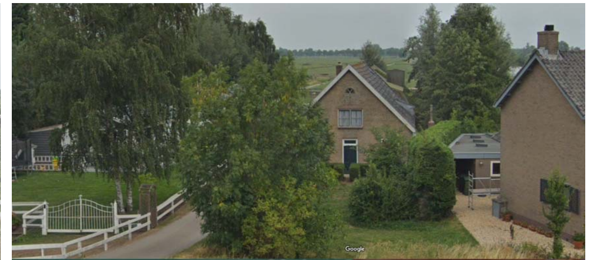
Karakteristiek ogende woning verkeert in bouwvallige staat.
