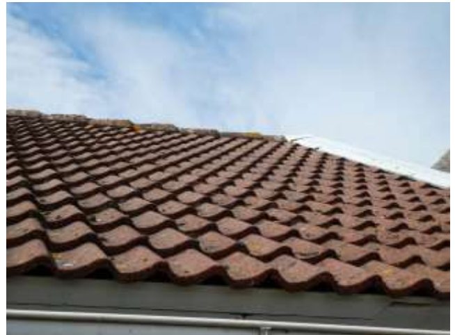
Figuur 14 Dak paardenstal
