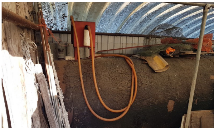
Foto 7: voormalige bovengrondse dieselolietank in aanbouw
