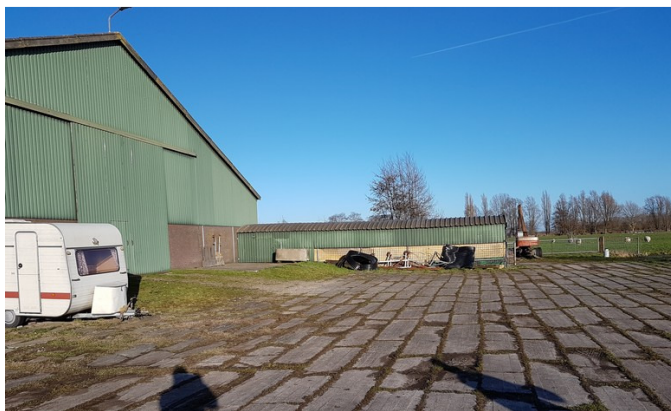
Foto 4: zuidelijk gedeelte locatie / machineberging en aanbouw (vanaf westzijde)
