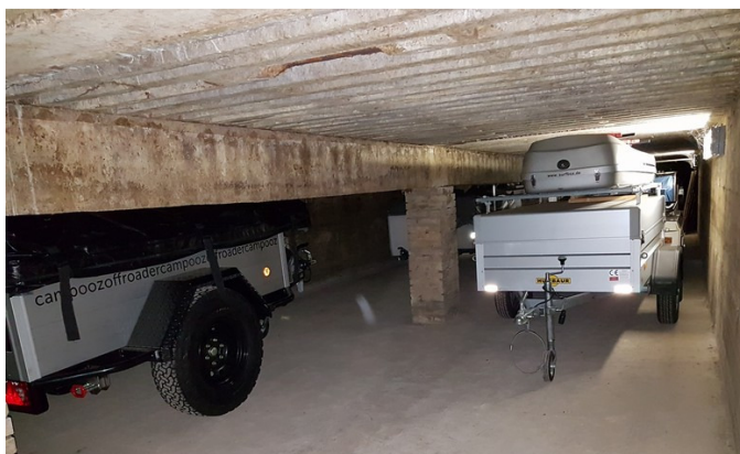
Foto 6: voormalige mestkelder, inpandig
