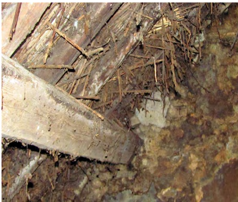
Figuur 7: Binnenzijde van het dak van de oude boerderij.
