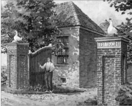
Hekpijlers van de voormalige steenplaats Ganssburgh in Haastrecht, op een aquarel van J. Verheul Dzn uit 1929. In: Gemeentelijke Archiefdienst Rotterdam.
