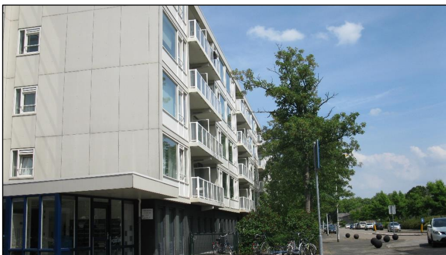
Foto 2: Zijaanzicht van appartementencomplex
