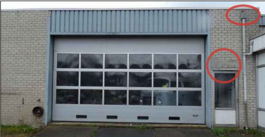
Figuur: Open stootvoegen en opening boven de hemelwaterafvoer waar vleermuizen kunnen invliegen/in weg kunnen kruipen.
