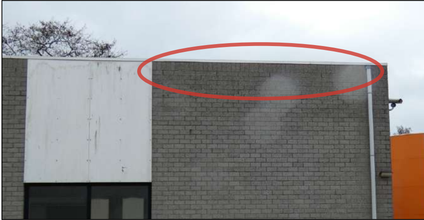
Figuur: Muur met open stootvoegen van het te slopen bijgebouw waardoor dwergvleermuizen de spouw kunnen betreden en benutten als verblijfplaats.
