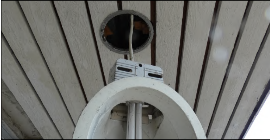
Figuur: Foto van de opening bij een loshangende lamp waardoor een broedvogels als de huismus de ruimte in het dak kan benutten als nestlocatie.
