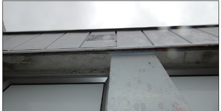
Figuur: Onder de dakrand zijn geen ruimtes aangetroffen waar vleermuizen in weg kunnen kruipen. Daarnaast is in dit voorbeeld de gevel van glad materiaal waar vleermuizen niet op kunnen landen.
