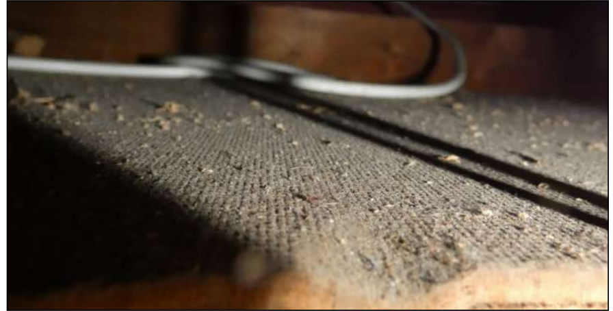
Figuur: Tijdens de nadere inspectie van de aanwezige ruimte in het dak bij de loshangende lamp zijn geen sporen van broedvogels of andere dieren aangetroffen.
