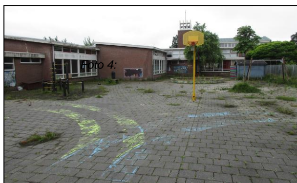
Foto 4: Te slopen schoolgebouw en bestrating binnen plangebied.
