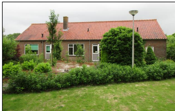
Foto 2: Te verwijderen woningen en begroeiing binnen plangebied.
