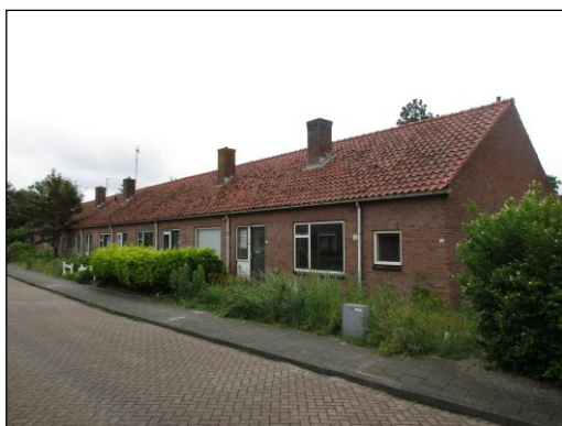
Foto 1: Te slopen woningen binnen plangebied.
