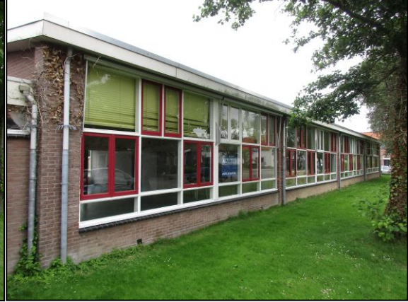
Foto 6: Te slopen schoolgebouw binnen plangebied.
