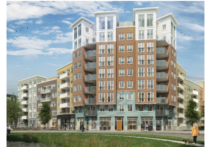
Verschillende balkonoplossingen waarbij de balkon half binnen en half buiten het volume steken
