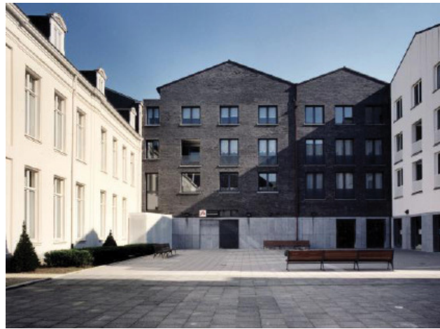
Grotere korrel voor het appartementenblok op het plein
