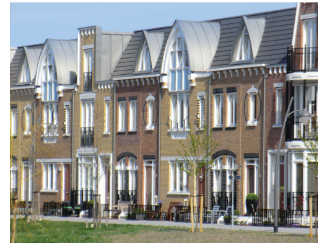
Verhoogde plint met een encroachment zone
