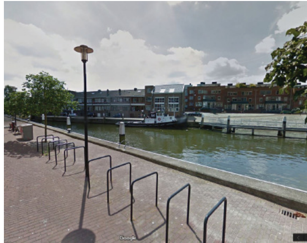
Betonnen deksloof op de kade
