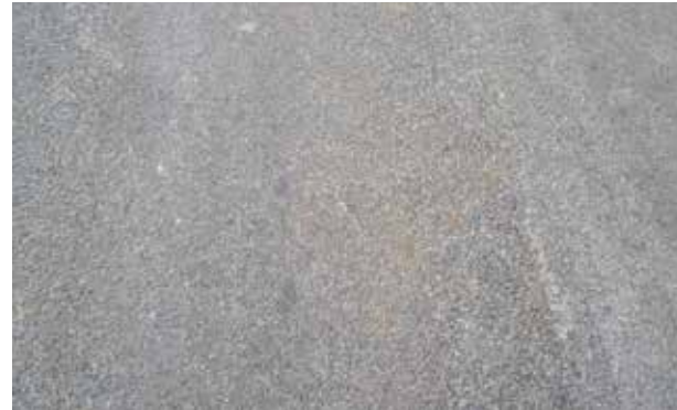
Asfalt voor het fietspad
