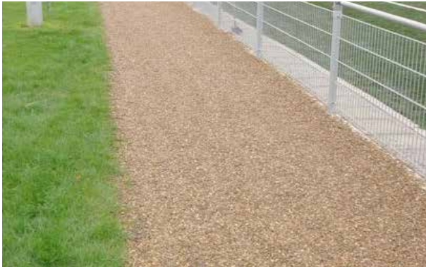
Voetpad uitgevoerd in asfalt, afgestrooid met split
