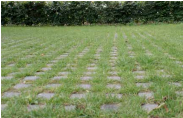
Grasbetontegels op de parkeerplaatsen voor medewerkers en toegangsweg naar gemaal Kok
