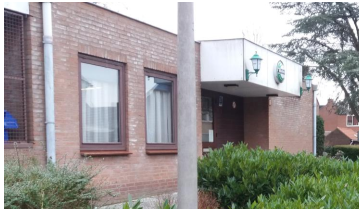
foto 4: Zuidoostzijde van het pand
