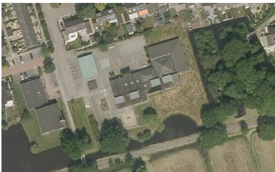
Afbeelding 4: luchtfoto bestaande situatie
