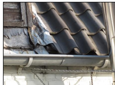
Figuur 5. Westzijde dakrand, met ruimte onder de onderste rij dakpannen.
