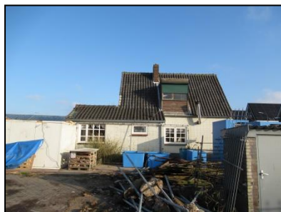
Figuur 3. Westzijde woonhuis, met puin op onderzoekslocatie.
