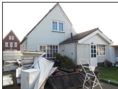
Figuur 4. Noordzijde woonhuis, hier is ook puin aanwezig.
