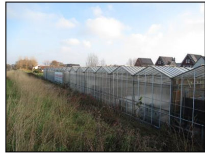
Figuur 8. Noordzijde van het kassencomplex, gezien vanaf de dijk.
