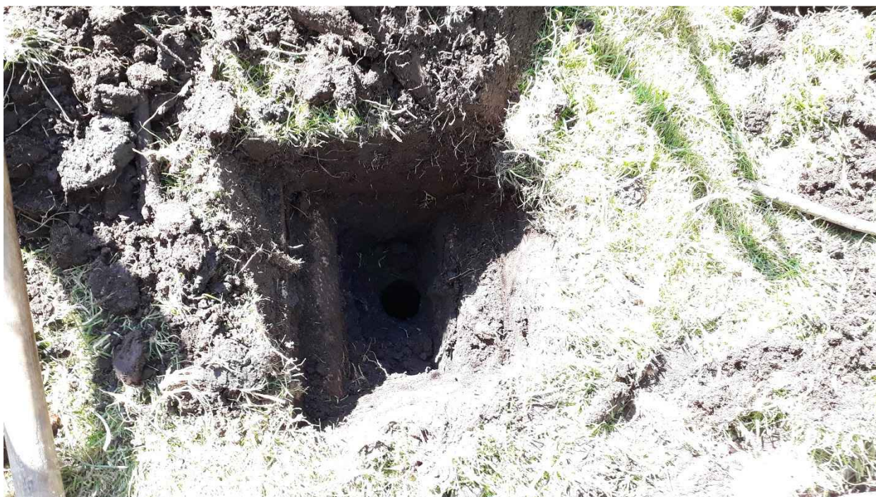
Foto 8: Proefgat A26, met asbestcementleiding en nabij de asbestplaat van foto 1
