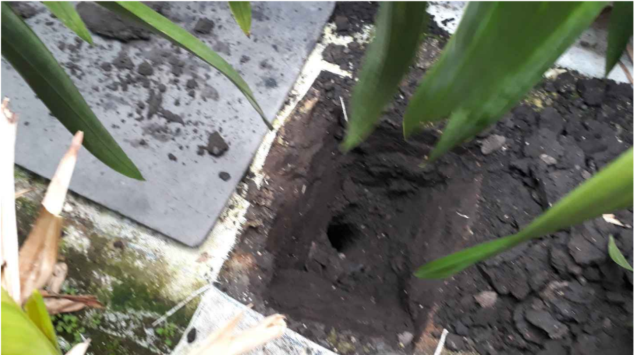
Foto 5: Proefgat A06, representatief proefgat van de proefgaten in de kas
