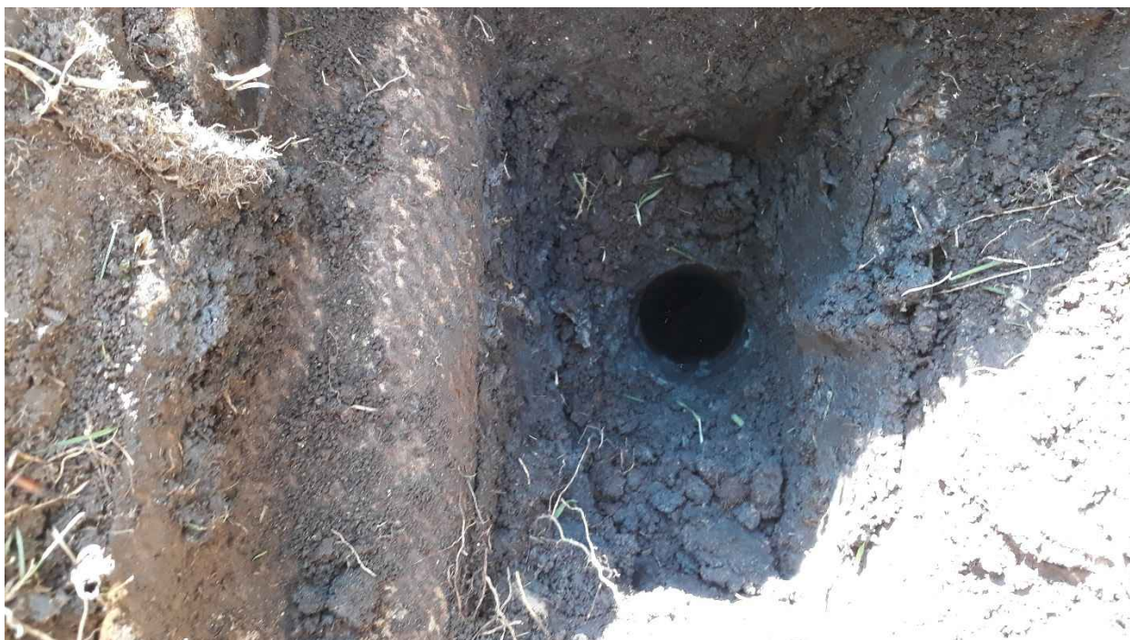
Foto 7: Proefgat A26, met asbestcementleiding en nabij de asbestplaat van foto 1
